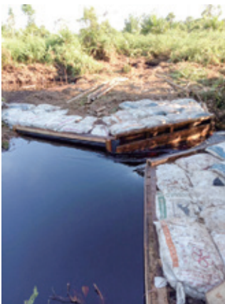
写真1 住民によって建設された小規模木製ダム
